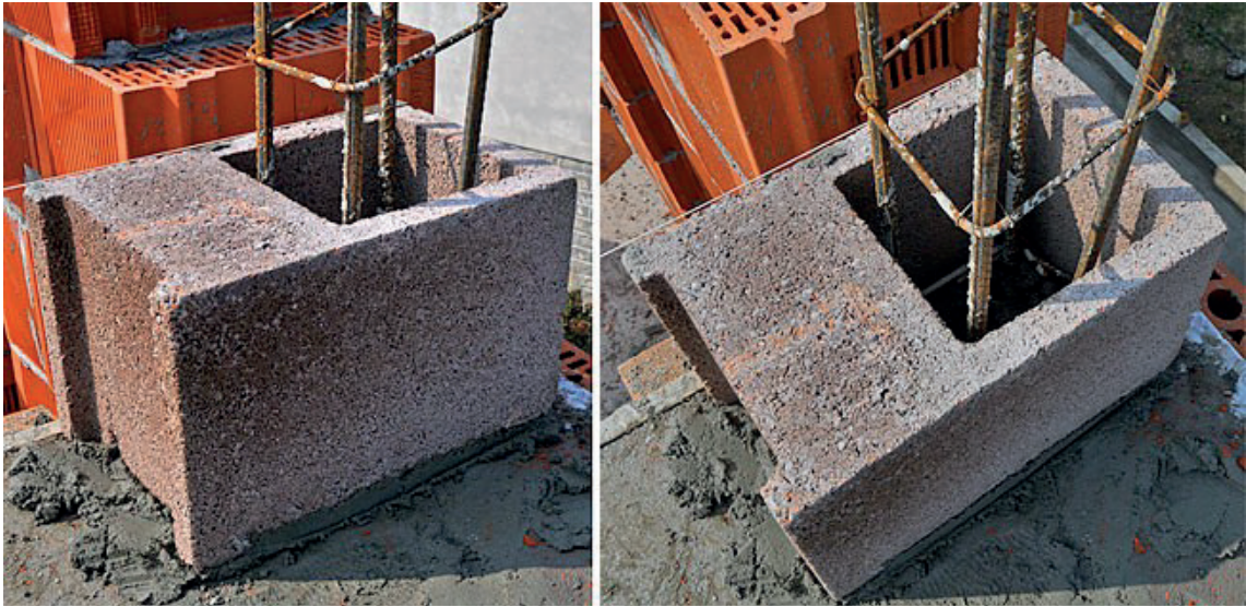
Сл. 115 Изведба на армиранобетонски столб со префабрикувани блокови наместо класична оплата
