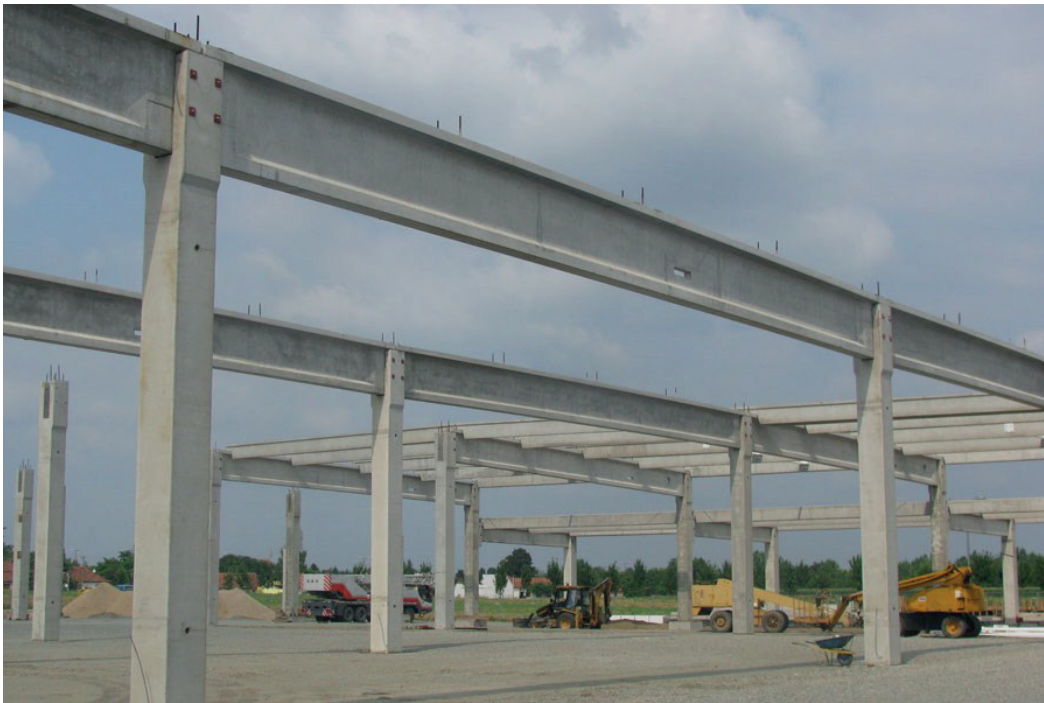
Сл. 86 Армирано бетонска рамка
