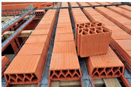
Сл. 34 Керамички блок „монта“ за меѓукатна конструкција
