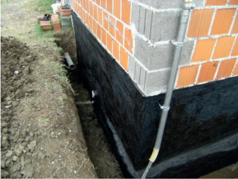
Сл. 101 Вертикална хидроизолација на ѕид со битуменски ленти
