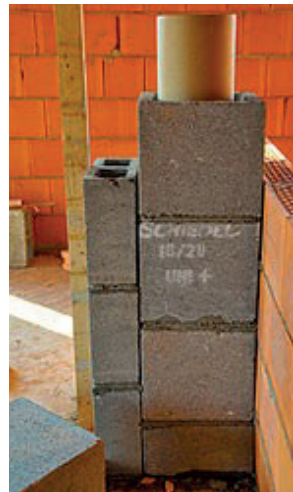
Сл. 117 Вентилационен канал од префабрикувани елементи
