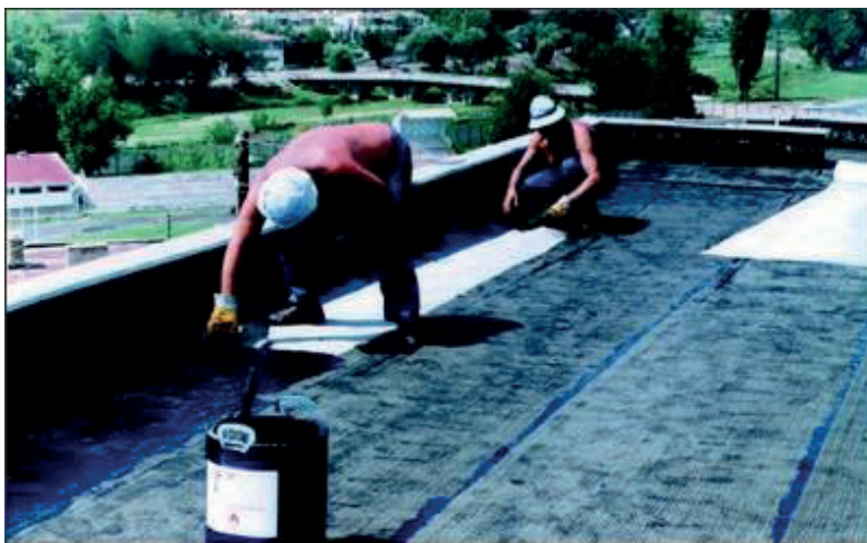
Сл.69 Хидроизолација на рамен кров
