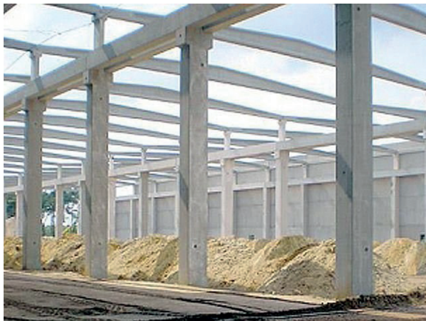
Сл. 85 Армирано бетонска рамка
