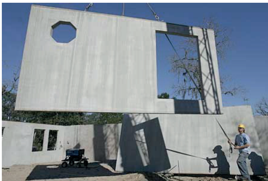
Сл. 105 Монтажни армиранобетонски ѕидови
