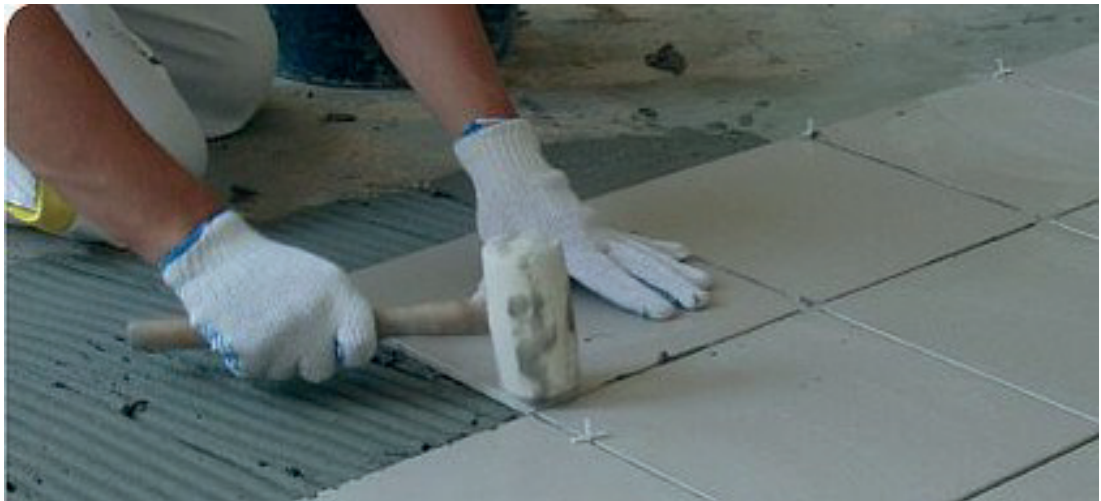
Сл.130 Поставување на подни плочки
