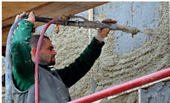
Сл. 53 Малтерисување на ѕидни површини
