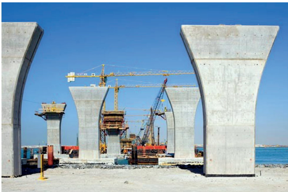
Сл. 114 Армиранобетонски столбови
